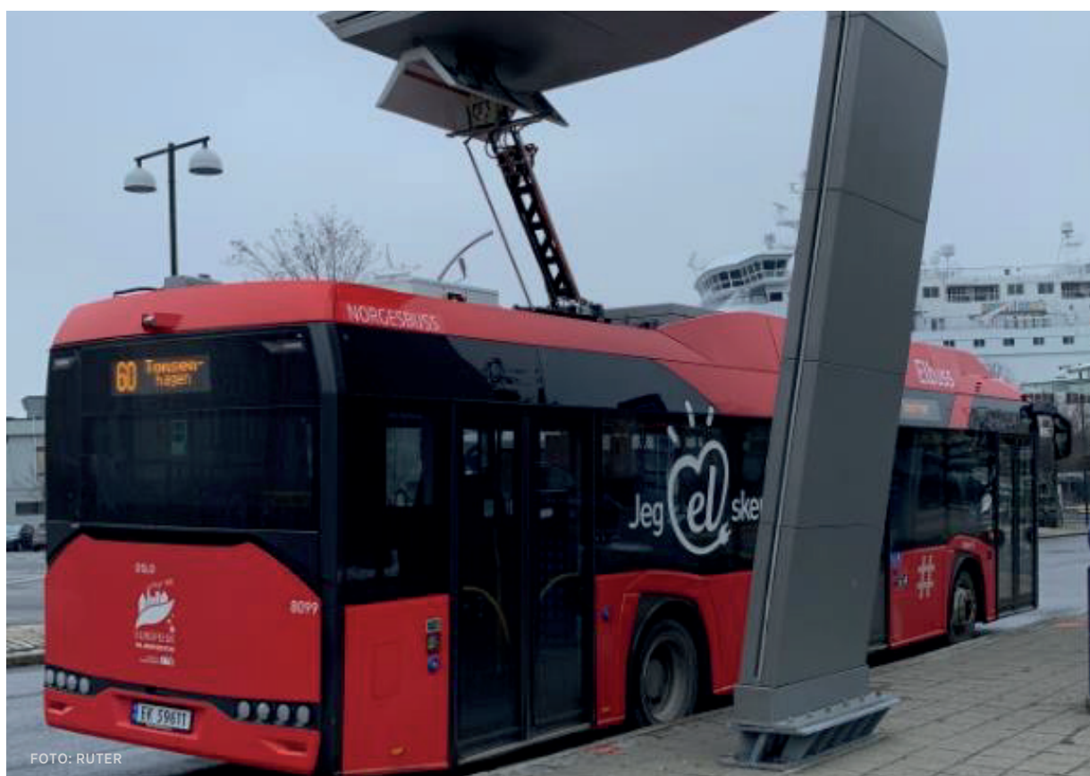
Lading av busser via pantograf.
