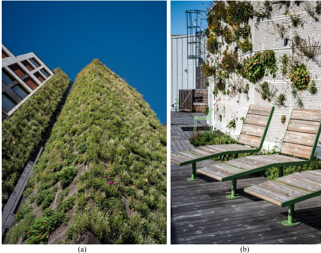
Figur 2-6: Grøne plantevegger på Oslo City, både på sjøve fasaden i (a) og på veggar på takterrassen i (b). Foto: Knut Neerland / magent.no.
