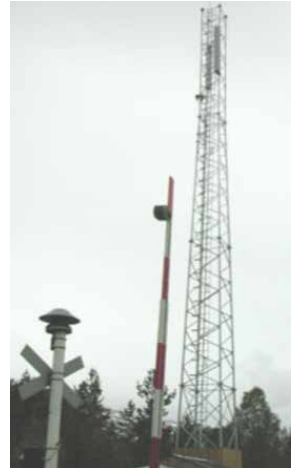
Mast for GSM-R-samband på Raumabanen.
