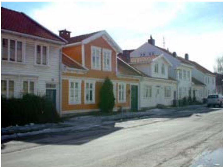
Figur 2-3 Tett trehusbebyggelse i Posebyen, Kristiansand. Foto: Kristiansand brannvesen.
