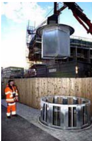
Figur 3-12 Installasjon av brannsikre søppelbeholdere Foto: Adresseavisen.
