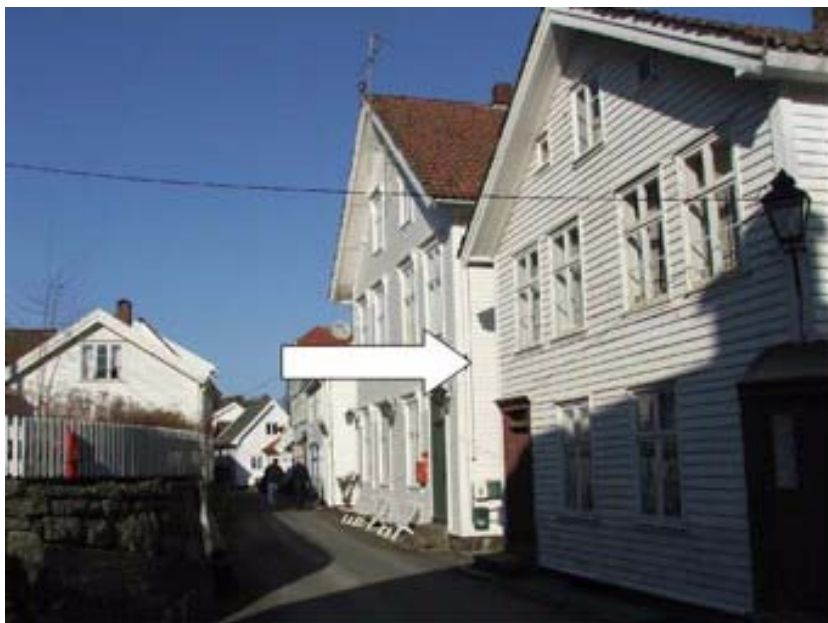
Figur 3-13 Hus med fasadesprinkling (se pil) i Sogndalstrand. Foto: Sokndal brannvesen.
