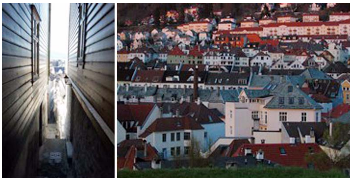
Figur 2-8 Tett trehusbebyggelse i Bergen. Bildet til venstre viser en av Bergens mange trange smug, mens bildet til høyre viser tett blandet bebyggelse i Sandvikssiden. Foto: Bergen Brannvesen.
