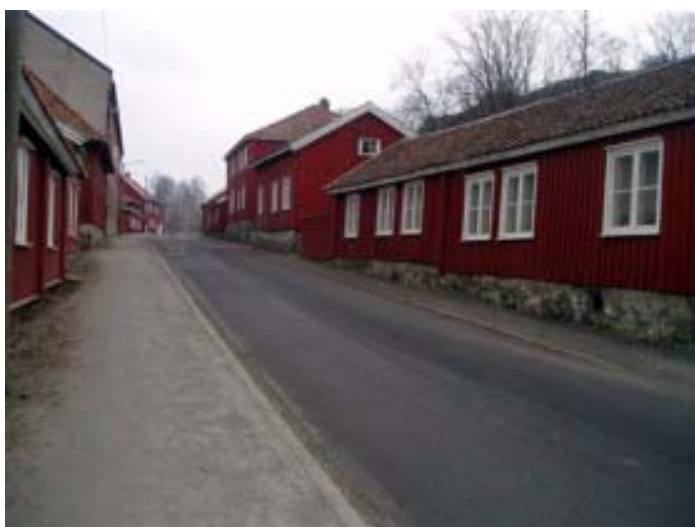
Figur 2-6 Tett trehusbebyggelse i Moss. Foto: Mossregionens brannvesen.
