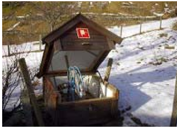
Figur 3-14 Sprinklerrom og slangepost som er plassert i den eldre bygningsmassen på Havråtunet. Foto: Osterøy brannvesen.
