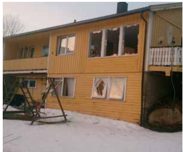
FIGUR 15. Gult hus – langsida mot sør.
