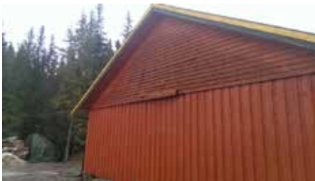
Fasade mot vest. Vegg buler.
