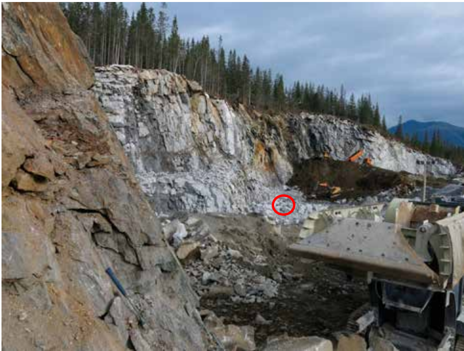
Foto 7. Bilde tatt fra pel ca. 4 810 mot nordøst. Fjellveggen sett på venstre side av bilde er av samme type berg som svakhetssonen sett på avstand, se foto 6. Stedet for eksplosjonen er omtrentlig innringet med rødt i bilde. Bilde tatt den 25. september 2014.
