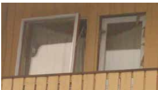
Langside mot sør, vestre del, 2. etg.
