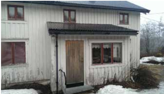
Fasade mot nord. Ingen skader.
