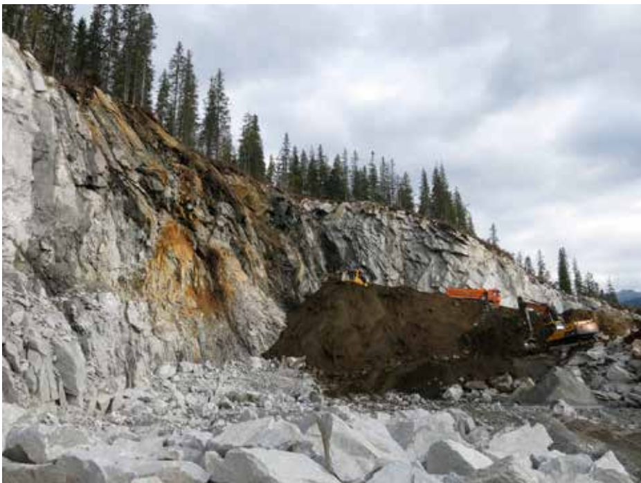
Foto 6: Sett fra eksplosjonssted mot fjellvegg i nordøst. Mørke fjellet er svakhetssonen som korse masseuttaket. Bilde tatt den 25. september 2014.
