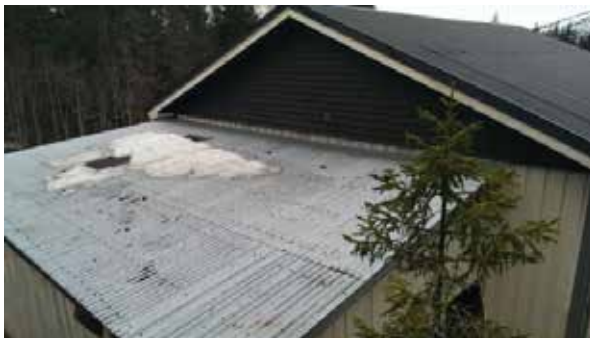
Blikkskur/påbygg på nordside.
