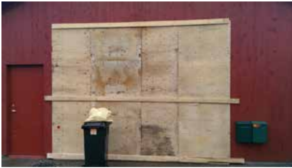
Vegg mot nord. Port trykket inn.
