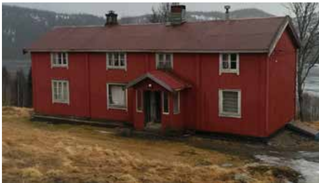
Fasade mot nord. Ingen vindu knust (nå).
